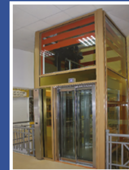
Облицовка шахты стекло триплекс
